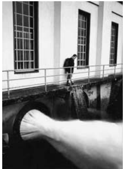
Heimbach. Zum Duschen nicht geeignet. Über 50 m weit schießt das Wasser der Rur aus dem Grundablass der Talsperre Schwammenauel. © Bernd Hermanns
